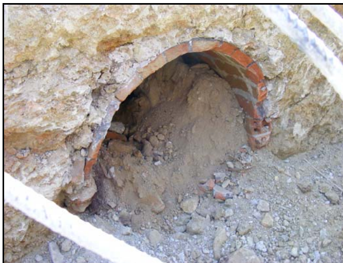
Aspecte inicial de la galeria.
