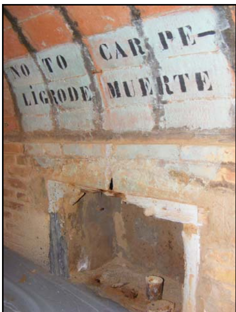
Detall de l'armari i el rètol de perill pel pas de conduccions elèctriques. S'observen també la presència de dues llaunes a l'interior. Al marge inferior esquerra es fa palesa la presència de formigó líquid identificat amb la U.E. 111.
