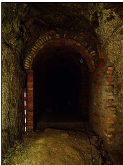
Vista des del tram 6 de la secció resultant del tram 5.
