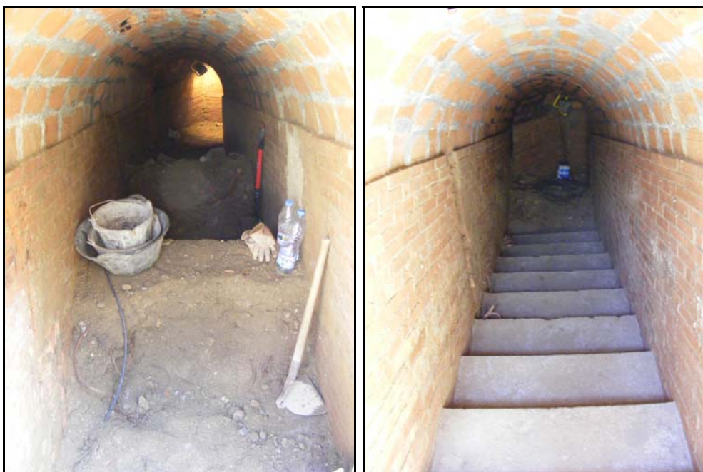
Procés d'excavació (U.E. 106). Primer tram d'esglaons.
