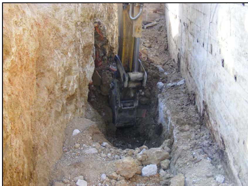
Procés d'extracció de terres en el frontal de la galeria.
