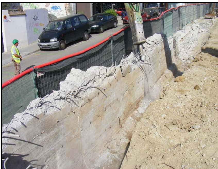
Inici afectació mur perimetral de formigó.
