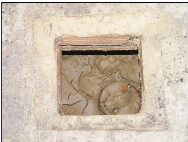
Vista de l'arqueta d'evacuació d'aigua.
