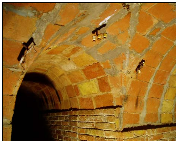
Detall dels punts 16 i 17. Vista general del nus de suports elèctrics format a la confluència dels trams 3, 4 i 5.
